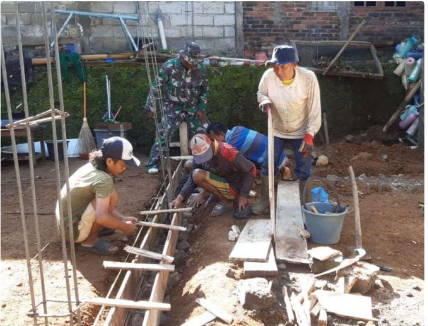
Pemasangan Bekisting Balok Sloof
